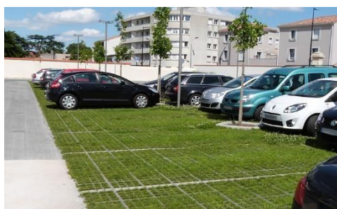
pavés joints engazonnés
