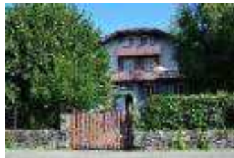
Clôtures anciennes : muret en pierre
