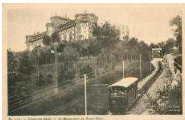
Le funiculaire en contrebas du Royal Hôtel en 1902 après son prolongement vers Neuvecelle
