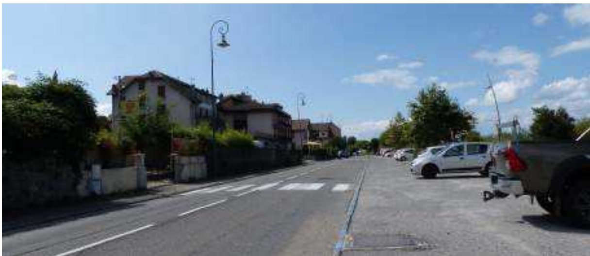
Traversée courte de la commune sur 400m au niveau de la RD1005 offrant un paysage très routier – Source : KARUM, 2021
