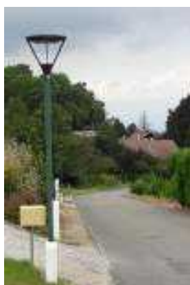
Nouveau lampadaire avenue du Tir aux Pigeons – Mairie de Neuvecelle
