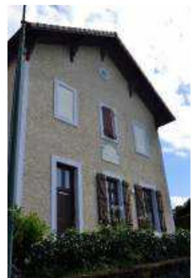
Ancienne école de Grande Rive
