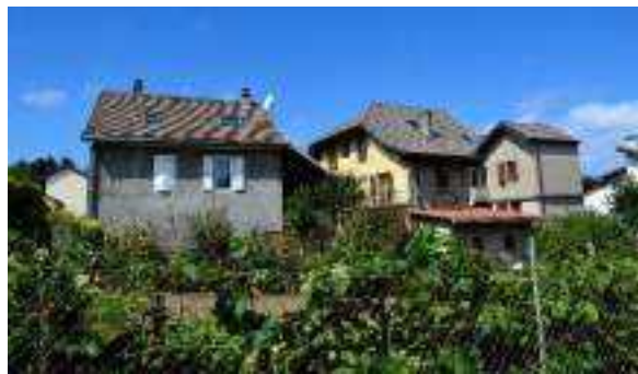
Maisons et villas XX e siècle, jardins ... en transition entre le village et le tissu pavillonnaire plus récent dans la pente (En Poêse)
