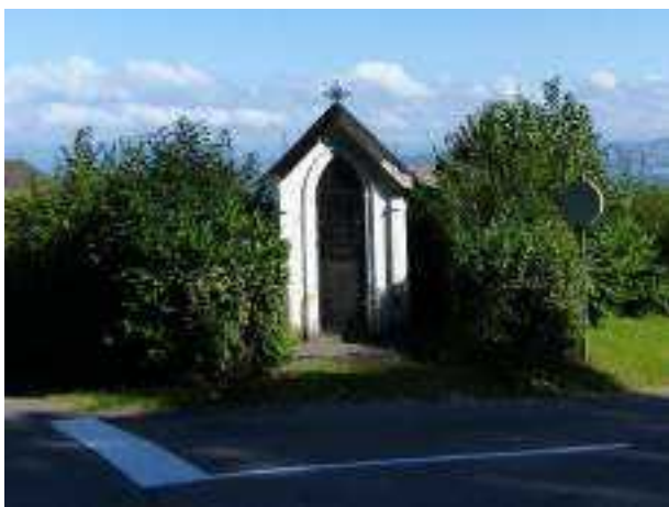
Oratoire avenue de Verlagny – Source : KARUM, 2021
