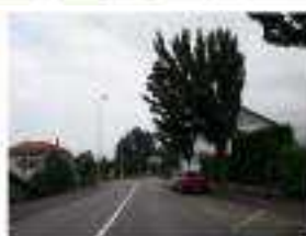
Av. de Milly au niveau du Moulin à Poivre
