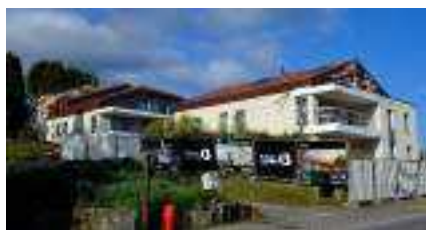
Chantier de logements collectifs à Lécherot
