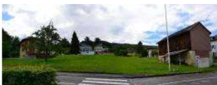
Espace libre de recul des maisons sur l'avenue du Léman
