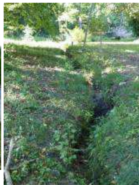
Ruisseau Chez Laurent au niveau du Parc de Neuvecelle – KARUM, 2021
