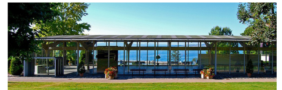
La buvette Prouvé Novarina, Evian, 1956. Lignes sobres, parois vitrées, couverture en aluminium, conservation de la vue sur le lac.
